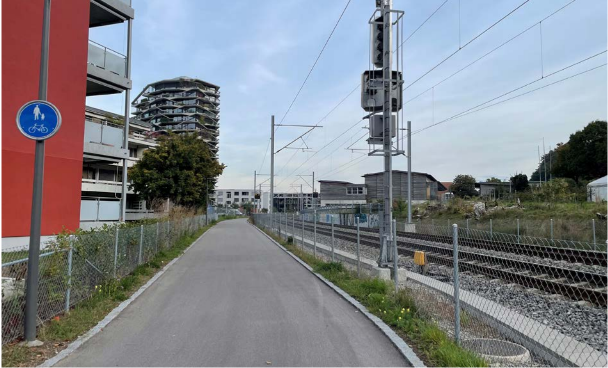
Abb. 16: Fuss- und Veloweg Wabern–Kleinwabern: Blick auf den Abschnitt zwischen Grünastrasse und Hochhaus Bächtele. Foto: Tanja Hug
