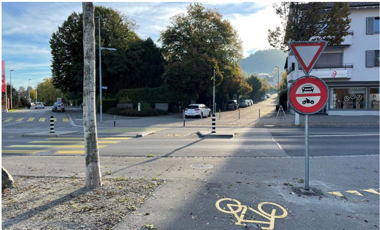
Abb. 11: Nachher: Die Ausfahrt wurde für den Autoverkehr gesperrt und damit die Sicherheit für den Fuss-/Veloverkehr erhöht. Velofahrende dürfen neu links abbiegen oder geradeaus fahren. Zudem wurden bei der Baumgruppe die Betonplatten entfernt und damit Stolperfallen eliminiert. Foto: Tanja Hug
