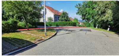
Burisholzweg, Niederscherli NACHHER: Einfache Massnahme mit grosser Wirkung. Die Eibe links wurde entfernt. Damit konnte die Sicht auf querende Zufussgehende wiederhergestellt werden. (Foto vom 29.06.2022)
