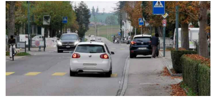
Schwarzenburgstrasse, Niederscherli VORHER: Der Kanton prüft die geforderten Verbesserungen im Rahmen des geplanten Deckbelagsersatzes (voraussichtlich 2025 oder 2026). Zur Debatte stehen beispielsweise eine Temporeduktion, durchgehende Velostreifen und neue Fussgängerstreifen-Mittelinseln. (Foto vom 20.10.2022)
